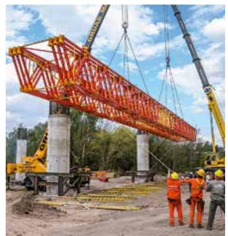
Die leichtgewichtigen Türme und Binderpakete benötigen zum Einheben keine Unterteilung in mehrere Einheiten.
