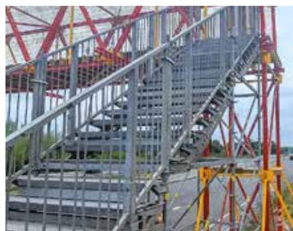
Sichere Zugangslösung durch die Kombination mit PERI Zugangstechnik.
