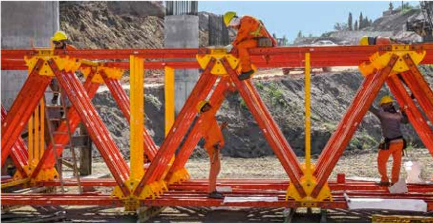
ALPHA-KIT lässt sich ohne Kran von Hand am Boden vormontieren – wenig Platz reicht aus. Damit eignet sich das Traggerüstsystem auch für den Einsatz auf Baustellen mit beengten Montageplatzverhältnissen.
