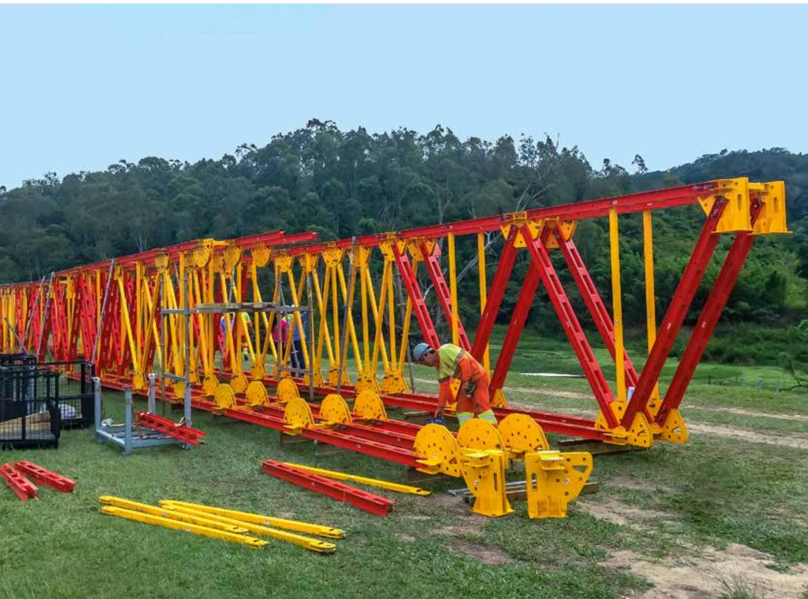
**Durch das leichte Gewicht der Stahlbauteile wird für die Vormontage der Türme und Binderpakete kein Kran benötigt. Aufgrund der leichtgewichtigen und somit ergonomischen Einzelbauteile kann das Zusammenbauen komplett ohne Hebemittel, nur von Hand erfolgen.**
