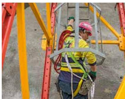
Sicherer Zugang zum Kopfspindelkranz durch den Leiteraufstieg.
