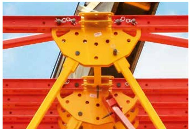
Das geringe Spaltmaß der Passbolzenverbindungen bedingt eine geringe Binderdurchbiegung und eine geringe Setzung der Türme.
