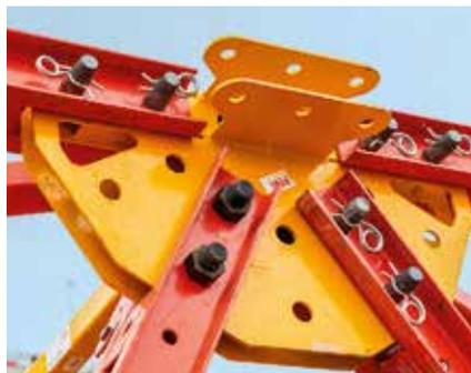
Wird eine Raumdiagonale am Gurtknoten montiert, werden anstelle von Passbolzen 2 Schraubverbindungen eingesetzt.
