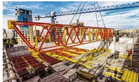
Zum Umsetzen mit dem Kran wird ein geeignetes 4-Strang-Gehänge eingesetzt, eine geringe Krankapazität reicht aus.
