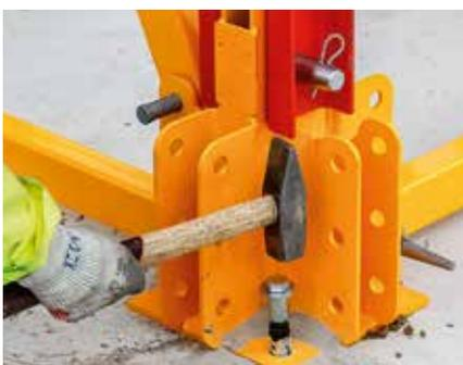
Zur Verankerung des Turms kann der Fußpunkt mit Dübeln fixiert werden.
