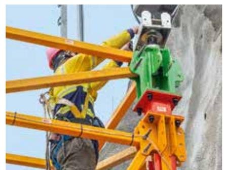
Im entlasteten Zustand kann die Kopfspindel von Hand eingestellt werden.
