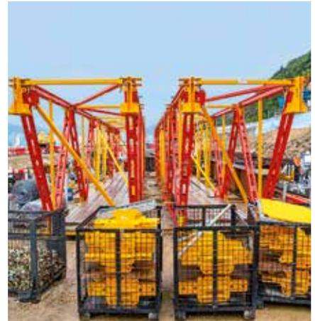
Vormontierter Binderpakete können platzsparend vor Ort bis zum Einheben zwischengelagert werden.
