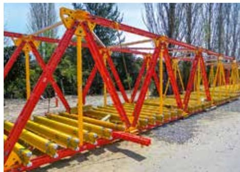
Um die Begehrbarkeit zu gewährleisten wird bei der Fußgängerbrücke die Horizontalaussteifung über eine einfache, clevere Lösung auf die Außenseite verlegt.
