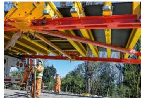
Für den Laufbelag können neben den gängigen VARIO Wandschalungskomponenten auch PERI UP Bauteile eingesetzt werden.
