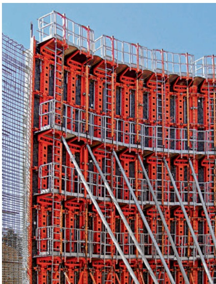
Mit den passenden Bühnen, Geländern und Leiteraufstiegen lassen sich sichere Arbeits- und Betoniergerüste erstellen.
