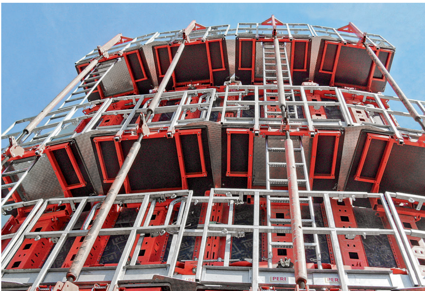
Mit den passenden Bühnen, Geländern und Leiteraufstiegen lassen sich sichere Arbeits- und Betoniergerüste erstellen.
