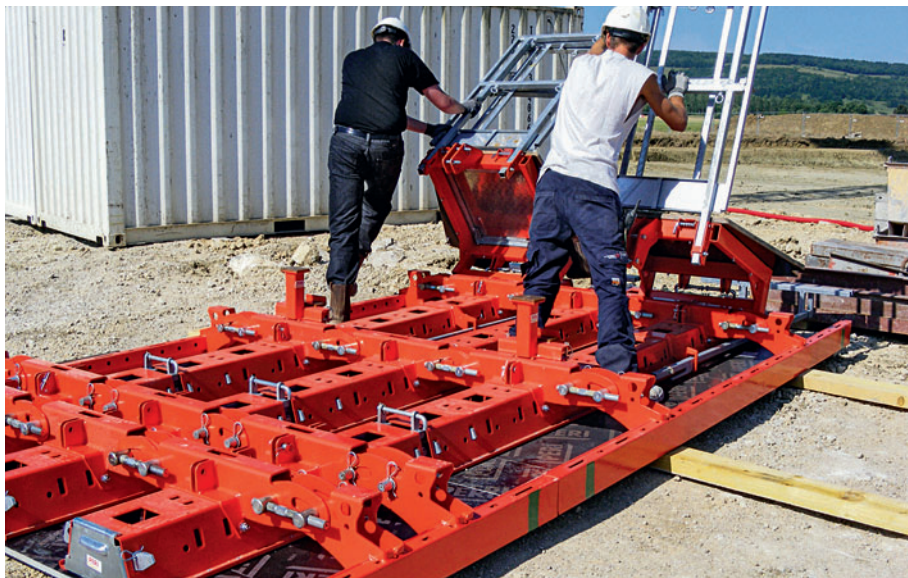
Die Montage des Zubehörs erfolgt am liegenden Element. Während des Umsetzens bleibt alles montiert.
