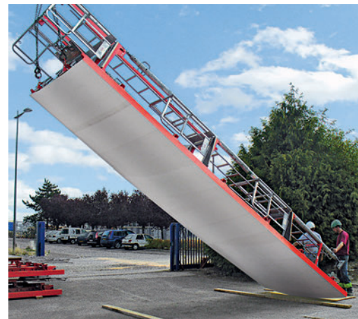
Die biegesteife und schlupffreie Aufstockung ermöglicht große Umsetzeinheiten.
