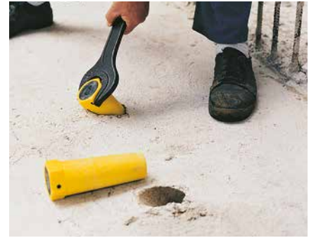
Die Vorlaufkupplung kann nach dem Betonieren wiedergewonnen werden.
