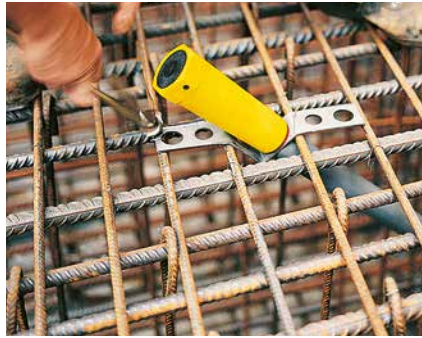
Mit dem V-Ankerhalter, als verlorenes Teil, ist eine exakte Ausrichtung des Zugankers auf 45° möglich.
