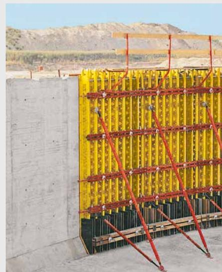
Die Anvoitung am Übergang Boden – Wand wurde zuvor an der VARIO Wandschalung mit abgebunden und bildet gemeinsam mit dem Element eine Umsetzeinheit
