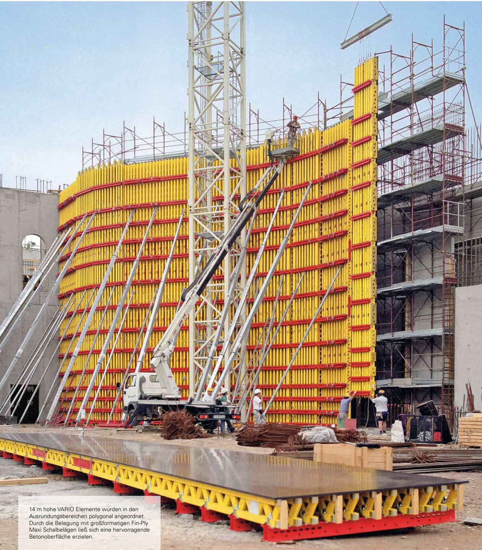
14 m hohe VARIO Elemente wurden in den Ausrundungsbereichen polygonal angeordnet. Durch die Belegung mit großformatigen Fin-Ply Maxi Schalbelägen ließ sich eine hervorragende Betonoberfläche erzielen.
