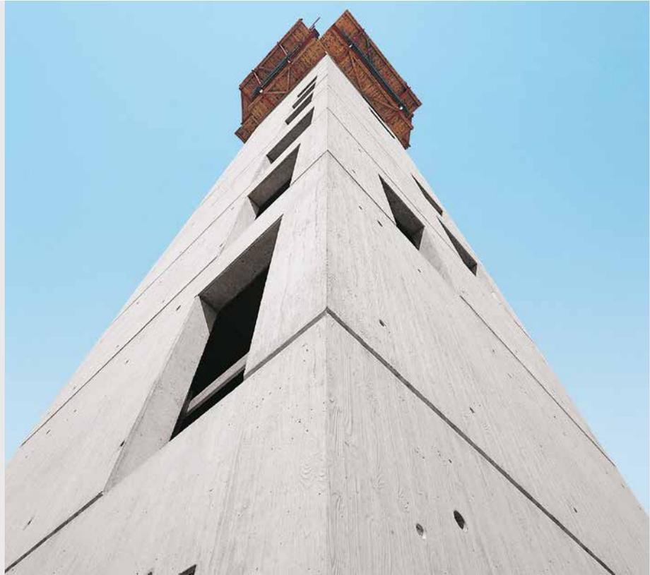
Optisch ansprechende Betonoberfläche mit rauer senkrechter Brettstruktur.
