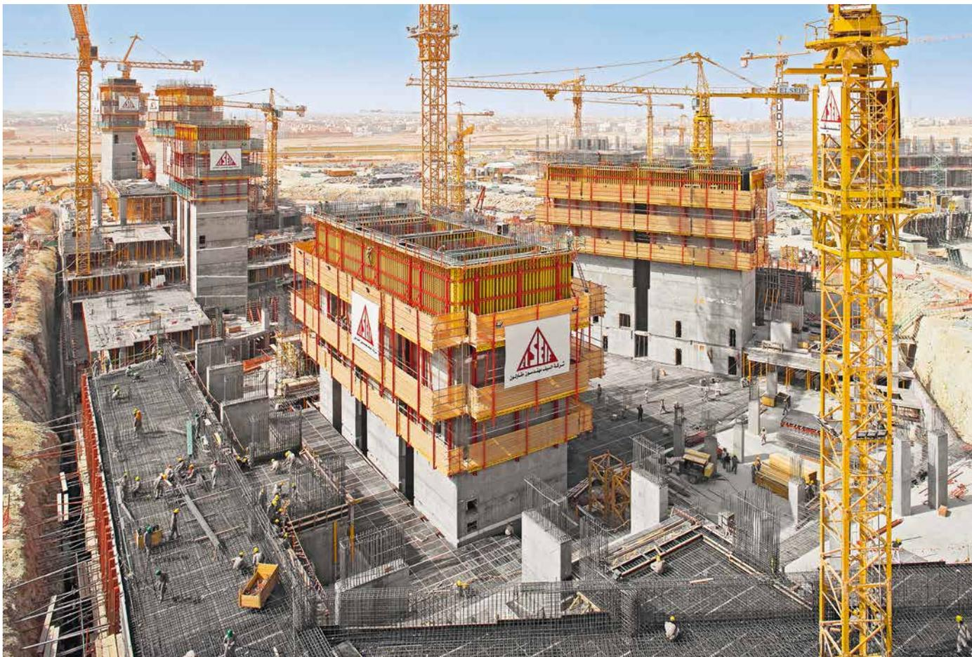
VARIO GT 24 auf RCS Schienenklettersystem beim Bau von Aufzug- und Treppenhauausschächten eines Hochhauses.
