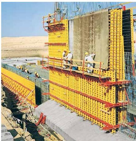
VARIO GT 24 beim Bau einer Kläranlage mit konisch verlaufenden Wänden.
