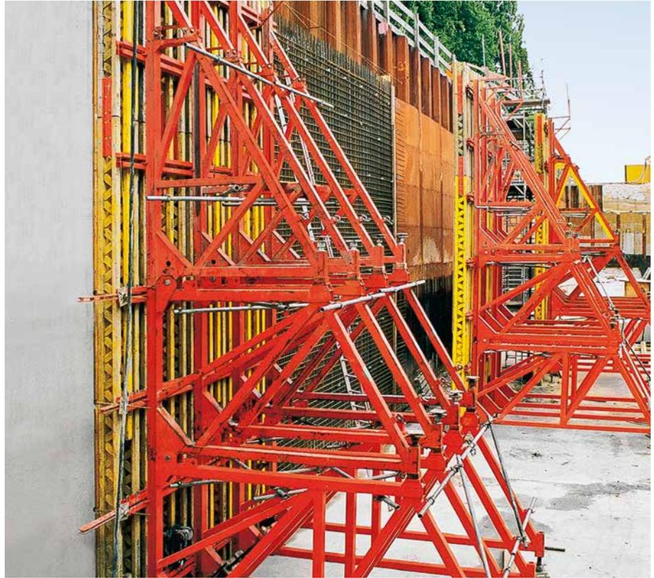
Max. Betonierhöhe von 8,75 m, Stützbock-A0, A, B und C mit Wandschalung VARIO GT 24.
