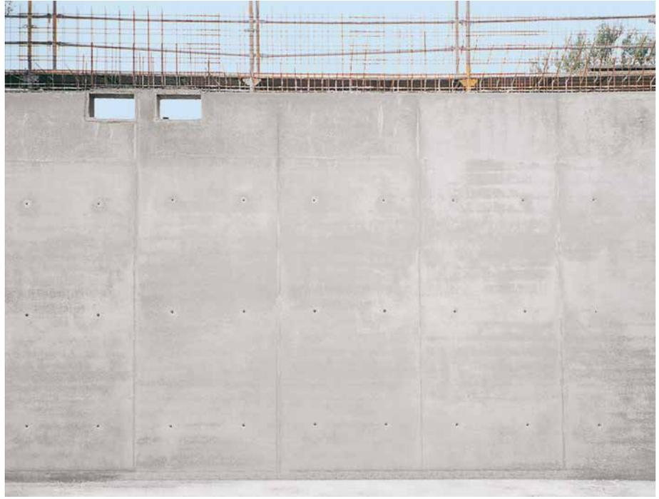
Ein geordnetes Ankerraster von 0,75 x 1,18 m und glatter, einfacher Sichtbeton sind das Ergebnis (Oberschulzentrum in Kletow).
