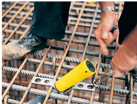
Einfaches Fixieren der Verankerung auf der Bewehrung: Mit Draht und Zange.
