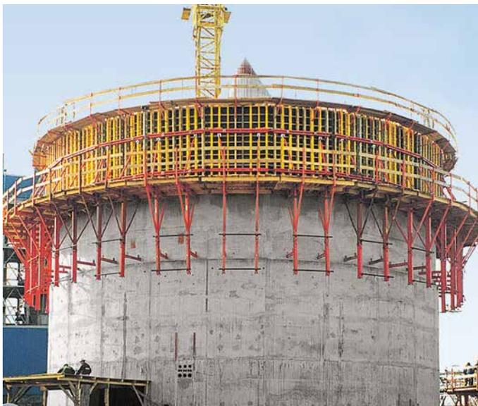
VARIO GT 24 beim Bau eines Rundbehälters. Holzkeile zwischen Träger und Stahlriegel geben die runde Form.
