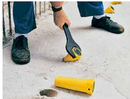
Die Demontage der Vorlaufkupplung erfolgt mit dem Einmaulschlüssel SW 70.
