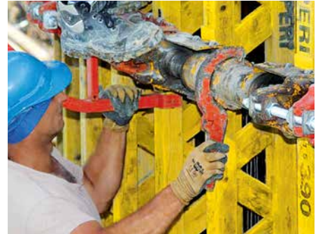
Einstellen des Gelenkspindelriegels GSRV mit dem Hakenschlüssel.
