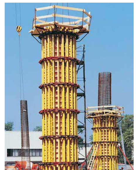
GRV im Einsatz für konisch verlaufende Rundsäulenschalung.
