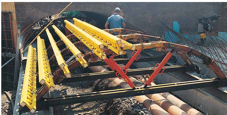
GRV Rundschalung und Stahlriegel als freitragendes Traggerüst für Bogenbrücken.
