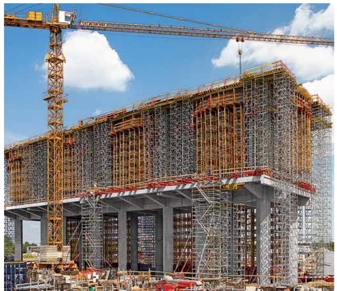
ST 100 Stapeltürme und das modulare MULTIPROP System, ideal kombiniert. Mietbare SRZ und SRU Stahlriegel des VARIO Wandschalungsprogramms dienen zur Lastverteilung.
