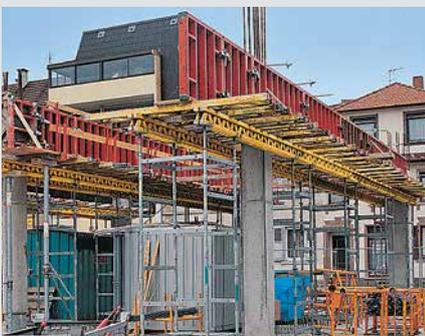
Mit dem ST 100 können schwere Unterzüge vorausbetoniert werden. Das geht sehr schnell, denn der ST 100 kommt häufig ohne Diagonalen aus.
