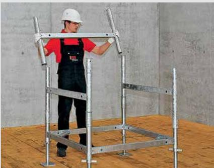
Der Stapelrahmen wiegt weniger als 7 kg und macht die Montage ergonomisch und schnell.
