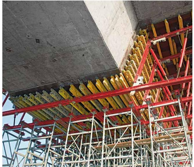
Die Gespärreeinheiten ließen sich am Brückenüberbau verankern. So konnte die Tragkonstruktion abschnittsweise für den nächsten Takt demontiert werden.
