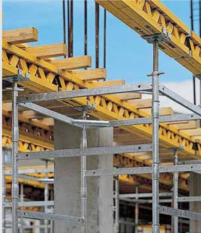
Auf der Kopfspindel kann nahezu jede Art von Jochträger verwendet werden, wie z.B. der Träger GT 24.
