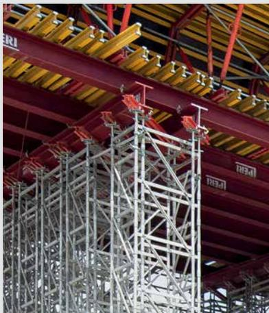
Bei großen Lasten nimmt die Gelenkkopfspindel serienmäßige PERI Stahlprofile wie beispielsweise SRU oder RCS Profile sowie Stahlriegel oder andere Stahlprofile auf.
