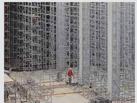
Bei großen Höhen wird der ST 100 liegend vormontiert. Die Diagonalen machen ihn für den Krantransport zugfest.
