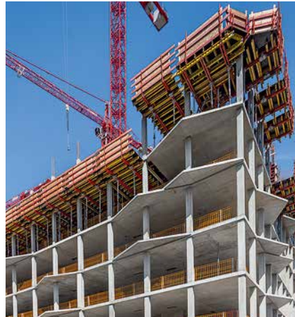
Deckentische mit GT 24 Trägern und Stahlriegeln können entsprechend spezifischer Geometrien geplant und montiert werden. Die Einheiten lassen sich mithilfe einer Umsetzgabel schnell umsetzen.
