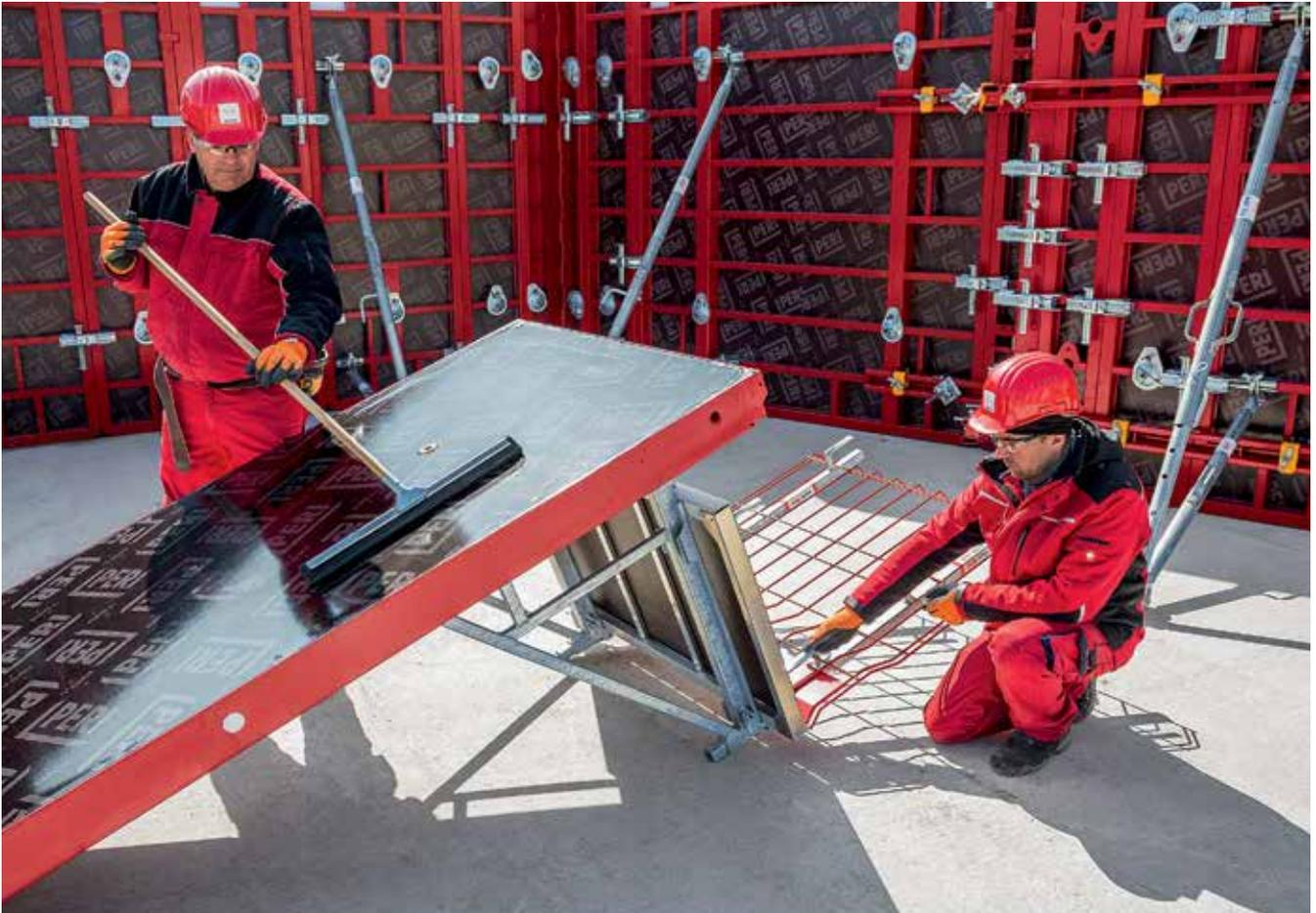
**Zum Zwischenlagern oder zum Reinigen der Elemente wird die Schalung auf dem Konsolensystem MXK abgelegt.**
