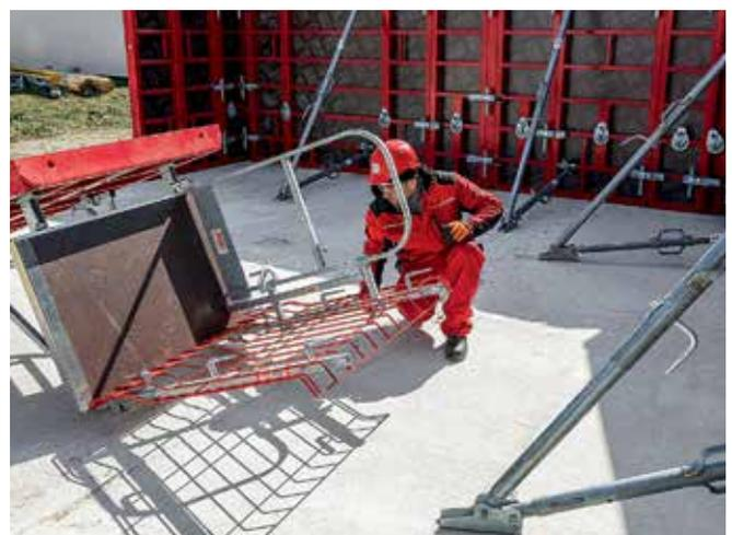
Das Schalungselement lässt sich mit montiertem Konsolensystem MXK rückseitig ablegen.
