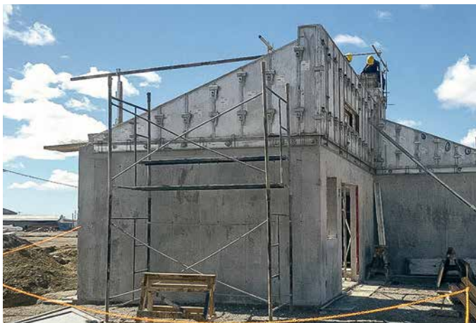
Auch schräge Wandoberseiten lassen sich mit UNO problemlos herstellen.
