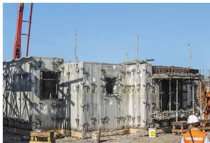
San Andres del Valle Wohnanlage mit Häusern in Concepción, Chile 455 Häuser mit 2 Geschossen Erdgeschoss mit 78 m 2 Grundfläche in Betonbauweise
