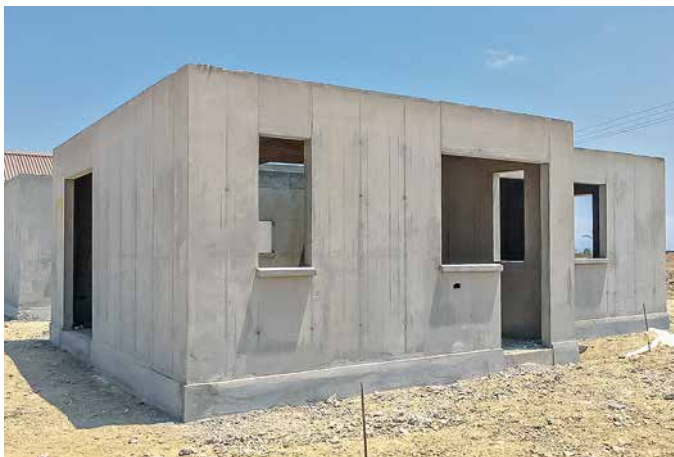
Altos del Mirador Wohnanlage in Coquimbo / IV Region, Chile 200 Häuser mit je 2 Geschossen Erdgeschoss mit 58 m 2 Grundfläche in Betonbauweise
