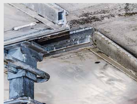
... und im Anschluss Deckenträger und -elemente ausgebaut. Die Stützen mit den Fallköpfen bleiben als Nachlaufunterstützung stehen.
