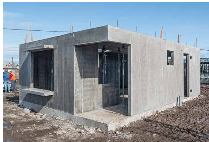
Casas Rehue Wohnanlage in Talca / Region Maule, Chile 350 Häuser mit 2 Geschossen Erdgeschoss mit 68 m 2 Grundfläche in Betonbauweise
