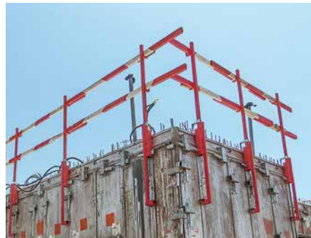
Der UNO Geländerpfosten-Kicker lässt sich am Wandelement befestigen, die Betonlasten werden direkt übertragen.
