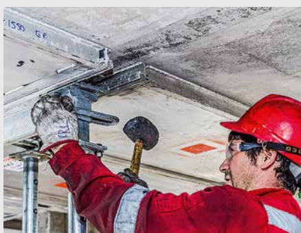
In den inneren Deckenfeldern werden die Fallköpfe durch einen Hammerschlag abgesenkt ...
