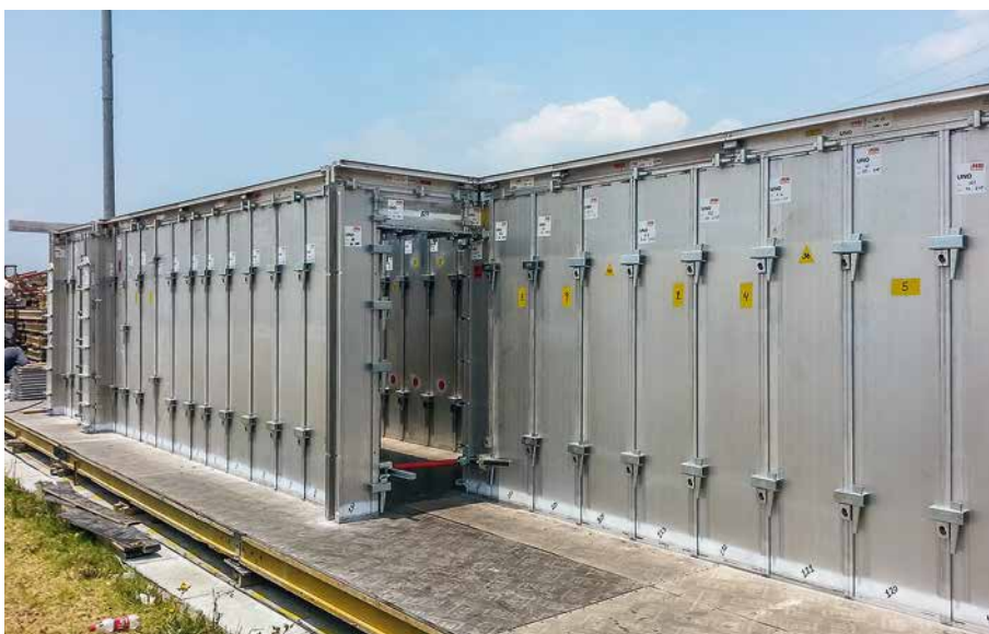
Vor der Auslieferung einer jeden Schalungseinheit wird ein Probeaufbau bei PERI durchgeführt. Eventuell sichtbare Mängel werden somit erkannt und beseitigt.
