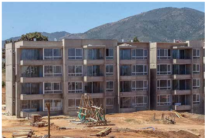
Lomas de Papudo Wohnanlage in Papudo, Chile 86 Häuser mit je 4 Geschossen 81 m 2 Grundfläche je Geschoss
