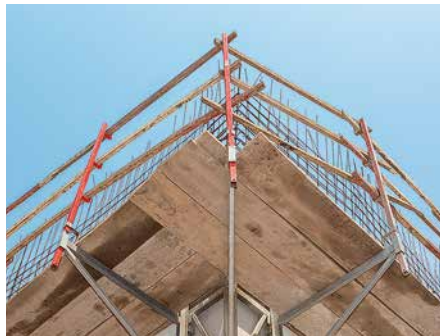
Mit Konsolen, Geländerpfosten und Holz lässt sich ein dreiteiliges Geländer erstellen. Bohlen dienen als Arbeitsfläche.
