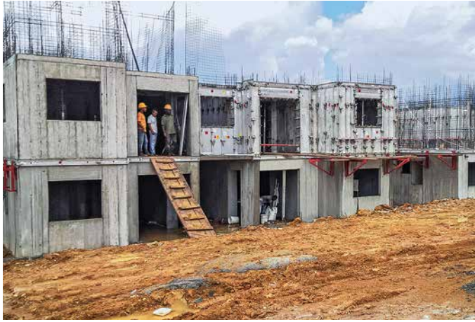
Las Bienaventuranzas Wohnanlage in Modelo, Dominikanische Republik 16 Bauwerke mit 4 Geschossen (2. Bauabschnitt) Je Geschoss 4 Wohneinheiten à 60 m 2
