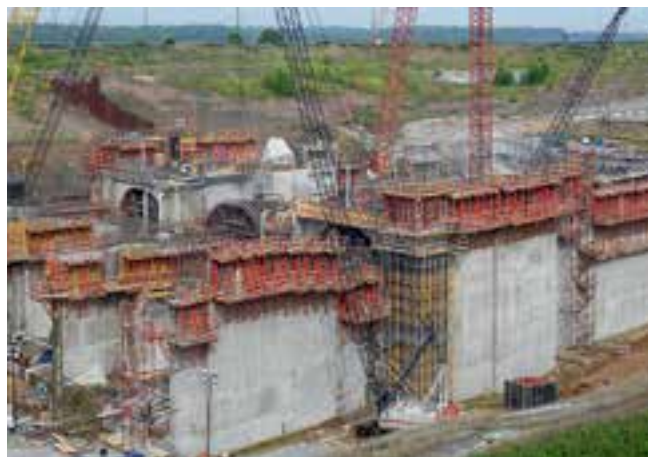
Die massiven Kraftwerkswände wurden mit dem Klettersystem SCS einhäufig geschalt und betoniert.
