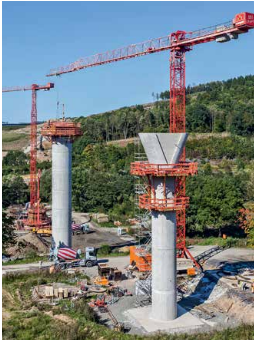
Für die Köpfe dieser Stahlbetonpfeiler einer Verbundbrücke bot SCS die optimale Lösung.
