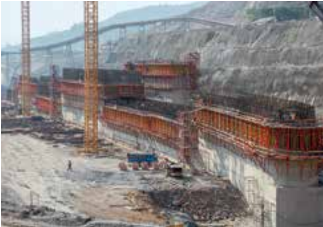
Die hohe Flexibilität des Klettersystems SCS erlaubt die Anpassung an alle Geometrien bei diesem Staudammprojekt.
