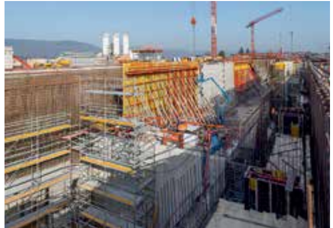
Umfassende Schalungslösungen und ein hoher Vorfertigungsgrad halfen, auch komplexe Bauwerksgeometrien in 15 m Tiefe zu bewältigen – einfach, passgenau und termingerecht.
