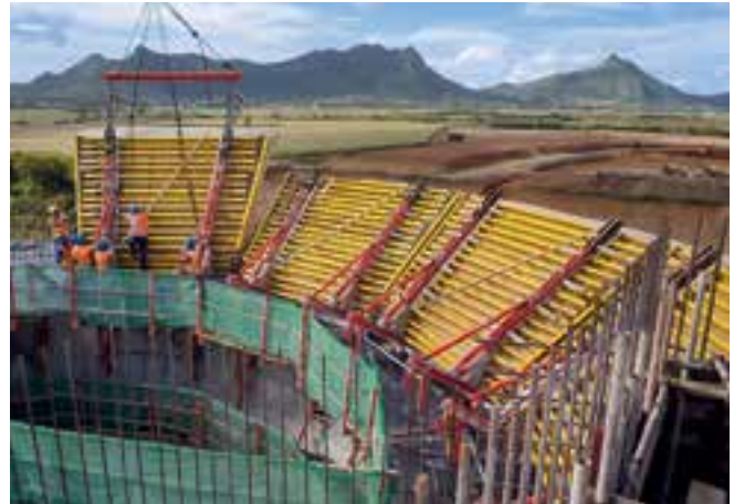
Spezielle Anhängpunkte sorgten dafür, dass sich die Schalungselemente einfacher mit dem Kran in die finale Position einheben ließen.
