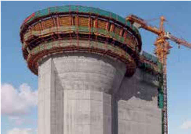
Freiformschalungen auf SCS Kletterkonsolen für einen großen Betontrichter.
