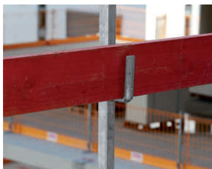
Die Aufnahmebügel an den Pfosten sind mit Nagel- bzw. Schraublöchern versehen, sodass sich Geländerbretter rasch fixieren lassen.
