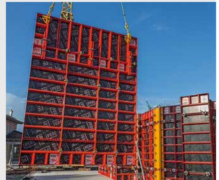
Aufstockungen sind mit horizontalen LIWA Elementen bis 3,85 m möglich. Der Ausgleichsriegel sorgt für die notwendige Kraftübertragung und Aussteifung.
