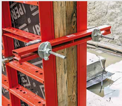
Die einfache Stirnabschalung mit Kantholz und Passplatte.
