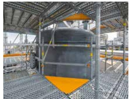
Zum lückenlosen Einrüsten von runden Anlagenbauteilen mit geringem Durchmesser kann auch das Eckblech genutzt werden.
