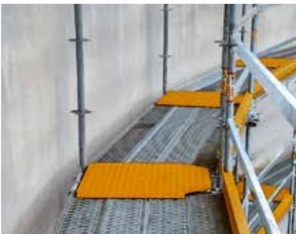
Ein Abdeckblech genügt, um die Belaglücken der gedrehten Gerüstfelder abdecken zu können, unabhängig vom Durchmesser der Rundbauten.
