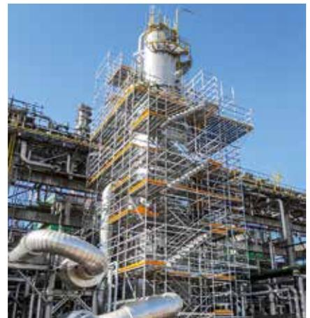
Für den sicheren Zugang lassen sich PERI UP Flex Treppen mit geschlossenen Belagflächen flexibel in die Gerüstlösung integrieren.
