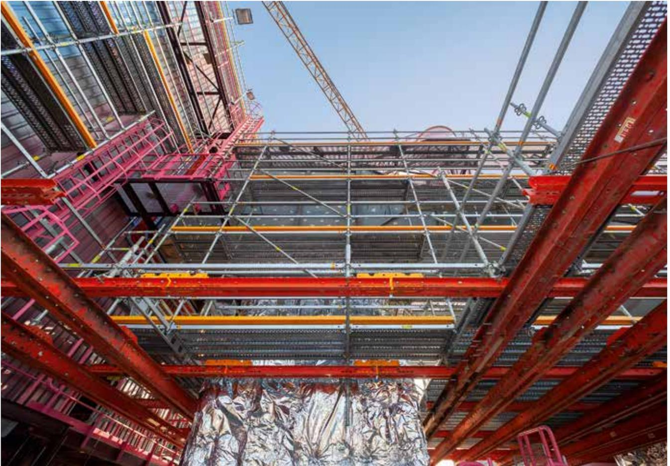
**Sind im Rahmen von projektspezifischen Lösungen Sonderkonstruktionen notwendig, lässt sich das Gerüstsystem mit mietbaren Stahlbauteilen des VARIOKIT Ingenieurbaukastens zu einer sicheren und wirtschaftlichen PERI Systemlösung komplementieren.**
