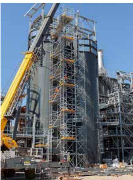
Gegenläufige Gerüsttreppen bieten eine große Kopffreiheit und kurze Laufwege bei hohen Aufstiegen.
