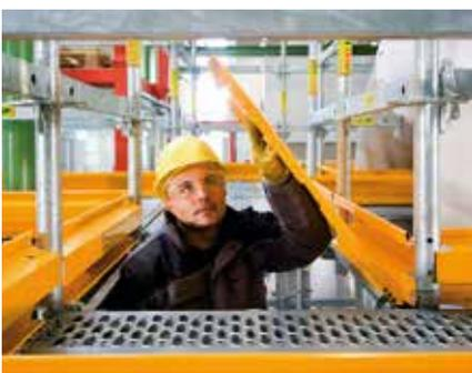
Die Klappen der Durchstiege lassen sich auch bei umlaufenden Bordblechen öffnen.
