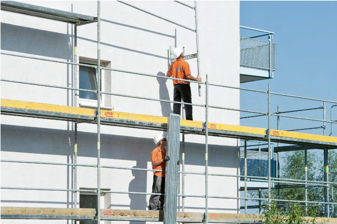
Das „vorlaufende Geländer“ z. B. beim Fassadengerüst PERI UP Easy sichert die nächste Ebene, bevor der Gerüstbauer diese betritt.
