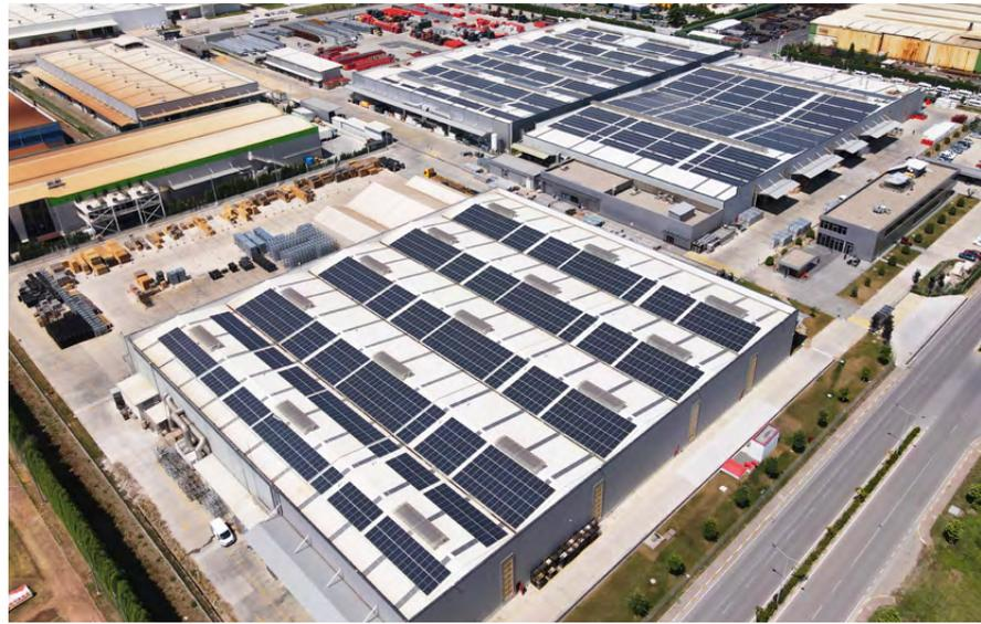
Die PV-Anlage in Sakarya, Türkei, deckt den gesamten Strombedarf dieses PERI Produktionsstandortes.
